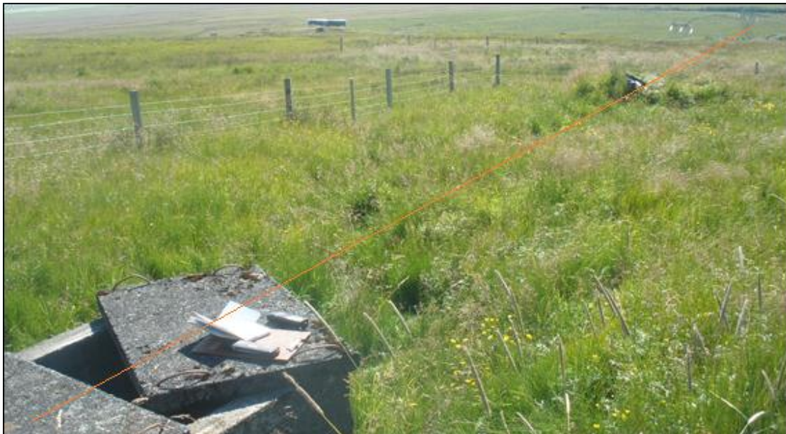
Mynd 4. Elsti brunnurinn er í forgrunni og þá plastbrunnur innan sömu girðingar. Líklegt er að þeir liggi á sömu sprungu. Í jarðskjálftunum 2000 varð vart við ljósleitt grugg í vatninu. Það bendir til að þá hafi orðið hreyfing á aðfærslusprungunni og væntanlega einnig hreinsun. Í baksýn eru miðlunartankarnir.
