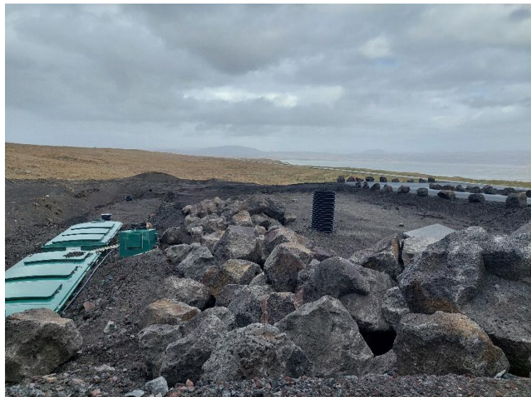
MYND 12 FRAMKVÆMDIR Í GANGI Á SUÐURLANDI VIÐ FRÁGANG HREINSISTÖÐVAR
