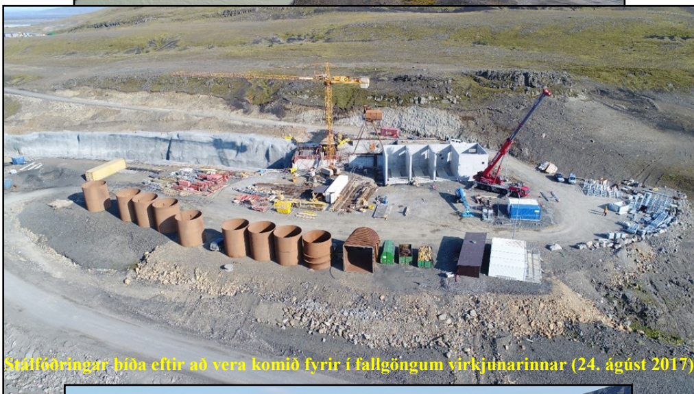
Framkvæmdir við inntakssvæði virkjunar (24. ágúst 2017)
