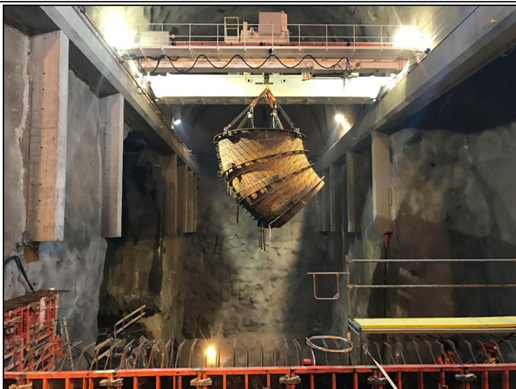
Niðursetning sográsareiningar í stöðvarhúsi (23.03.2017)
