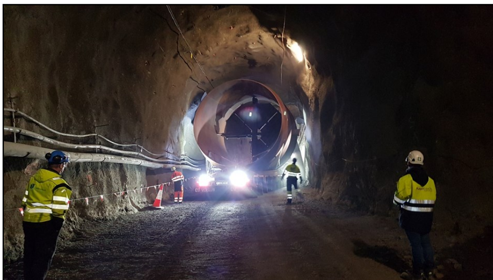
Bakkað með einingu stálfóðringar fallganga inn aðkomugöng stöðvarhúss (01.04.2017)
