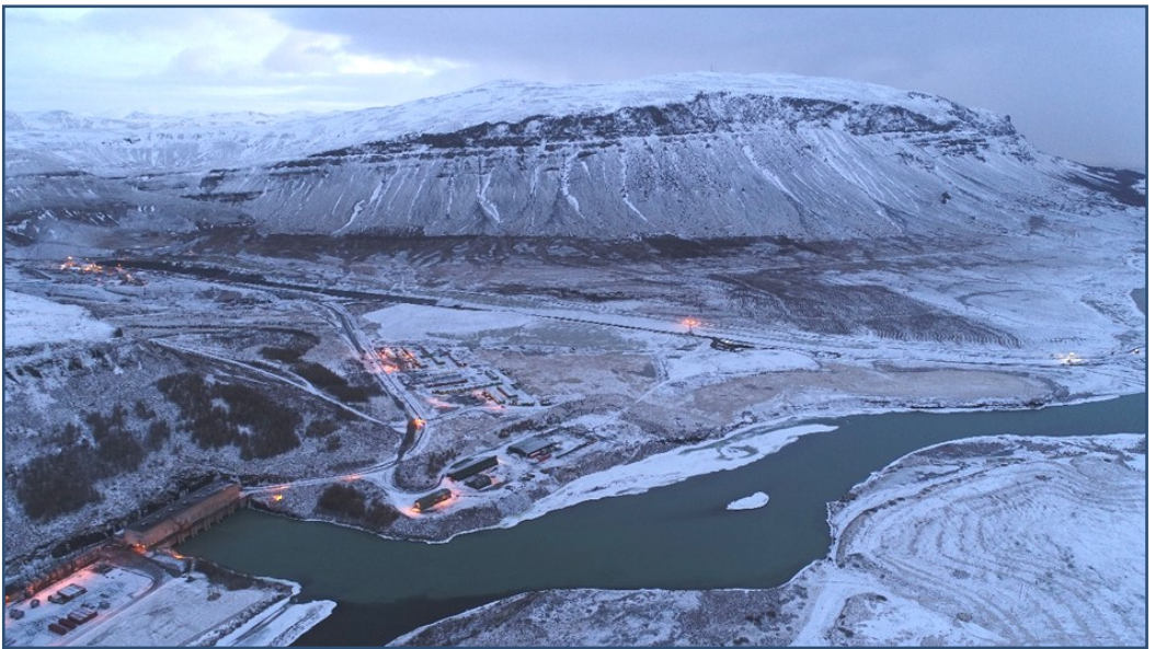
Vetraraðstæður á framkvæmdarsvæði stækkunar Búrfellsvirkjunar (10. janúar 2018).
