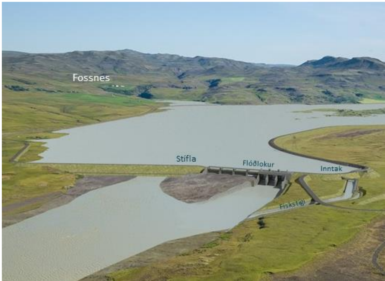
Mynd 5. Staðsetning og stærðarhlutföll stíflumannvirkja og lóns teiknuð inn á ljósmynd af svæðinu (Mannvit 2016).
